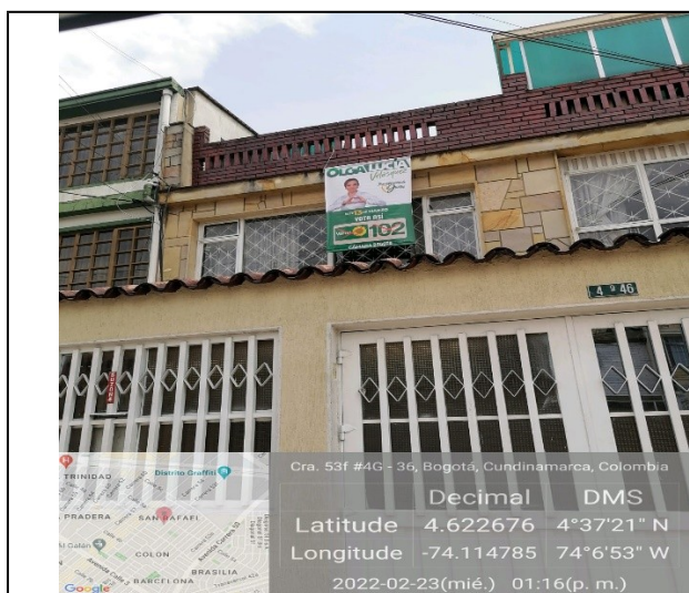
Un (1) elemento evidenciado en el inmueble, ubicado en ventanas.
